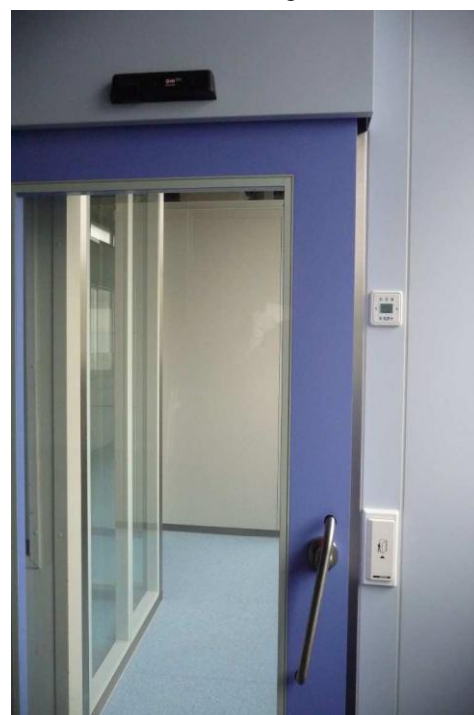
Automatisierte Schiebetür mit Bedienungseinheit und Sensorleiste
