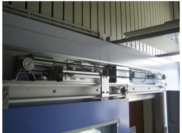
Laufschiene mit Antriebs- und Steuerungseinheit
