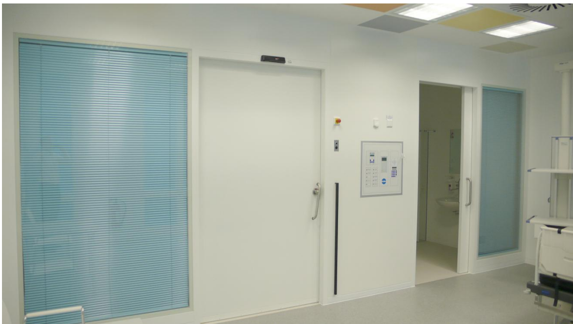
Reinraum-Schiebetür Typ S50-DS und Mittellichtelement mit elektrischer Jalousie
