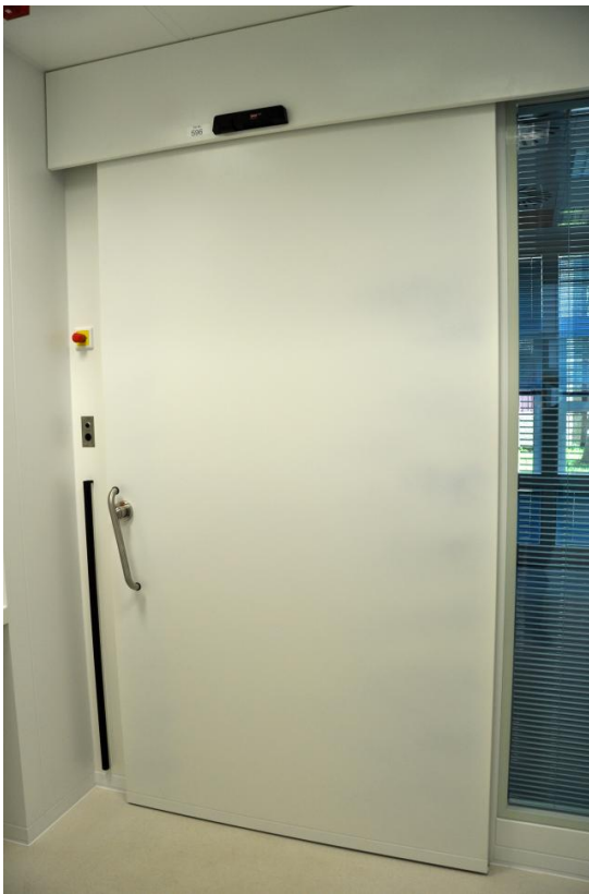
RR-Schiebetür dichtschießend Typ S50-DS mit Automatisierung und integrierter Rot/Grün-Anzeige
