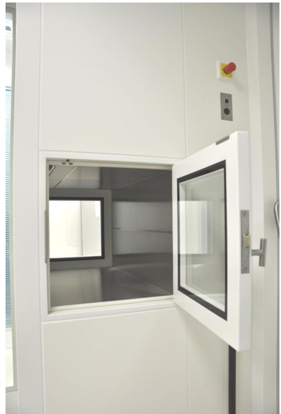
Materialdurchreiche mit Sichtfenster und Verriegelung
