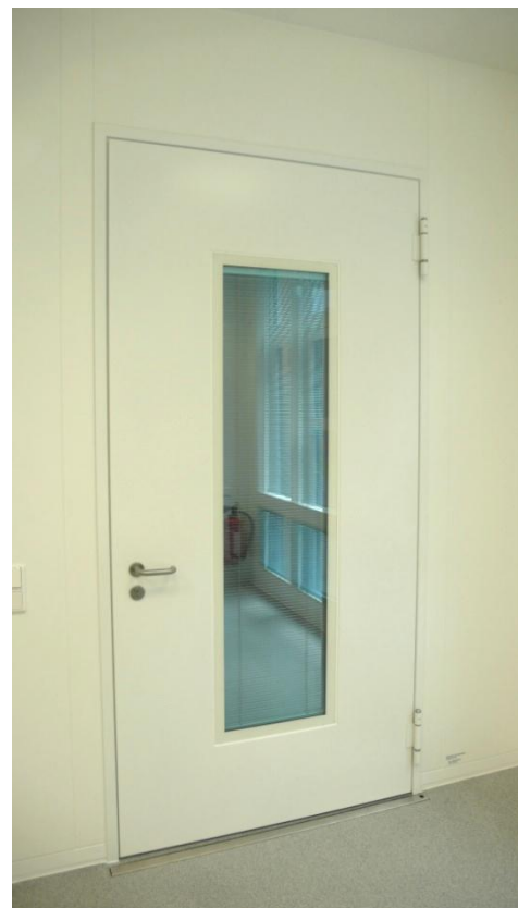
T-30 Brandschutzdrehtür mit Verglasung und Jalousie
