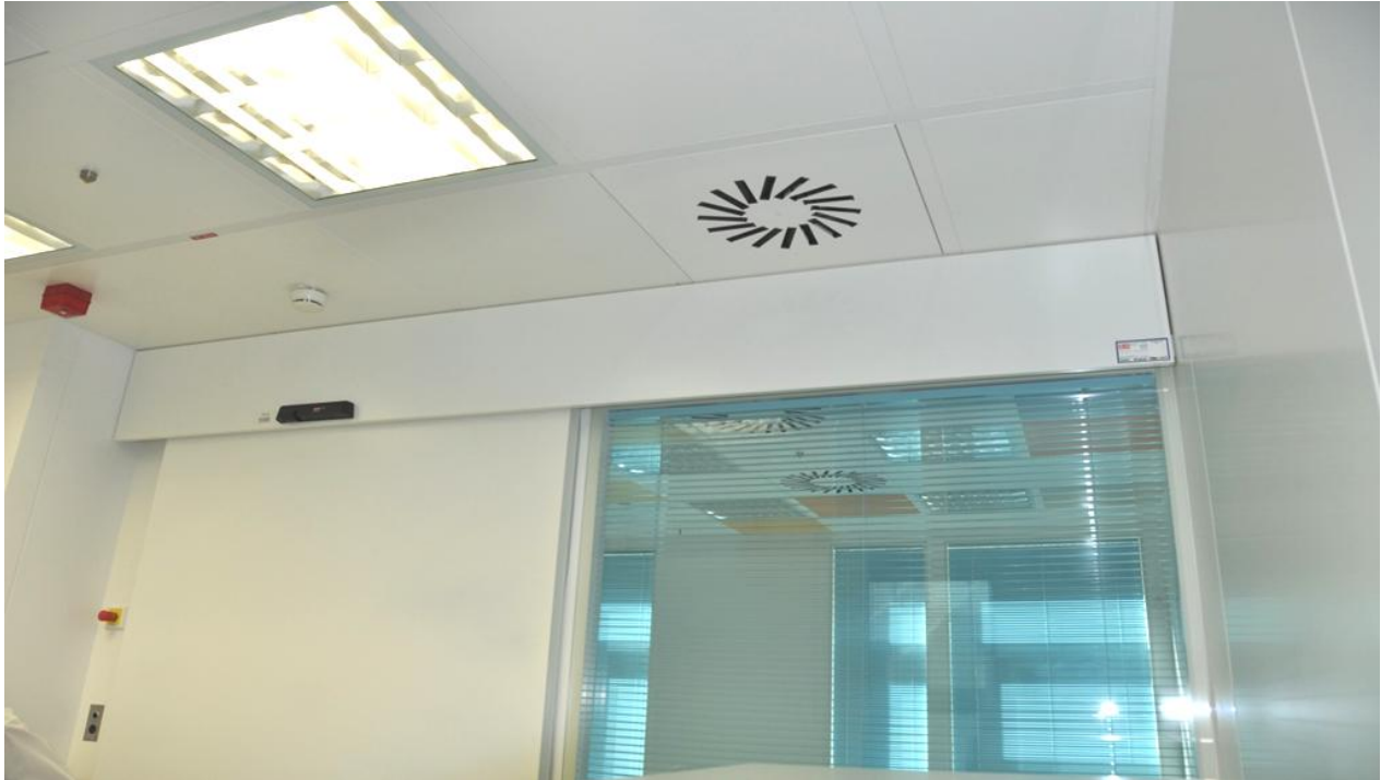
RR-Decke Typ VarioAccess mit Luftauslass und Leuchte
