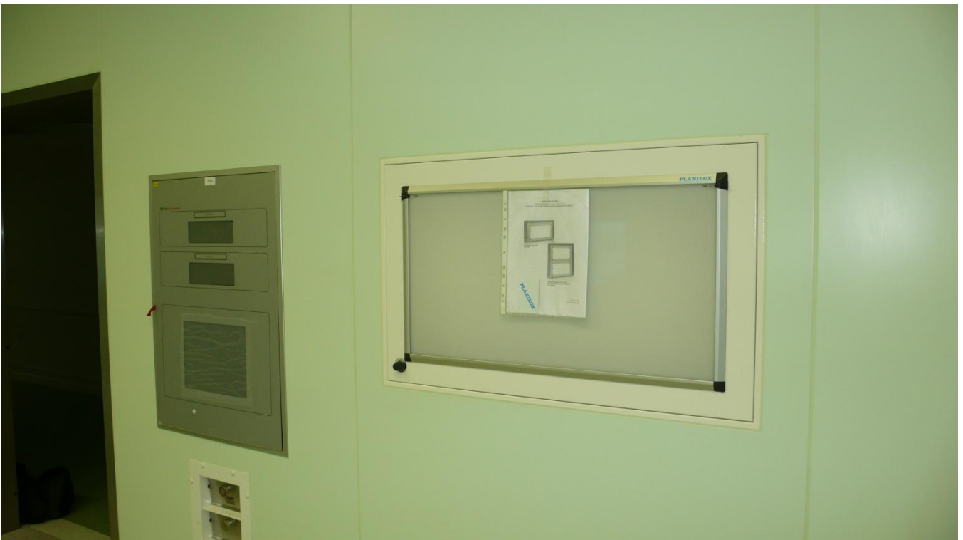
Flächenbündiges Bedienfeld und Röntgenfilmbetrachter
