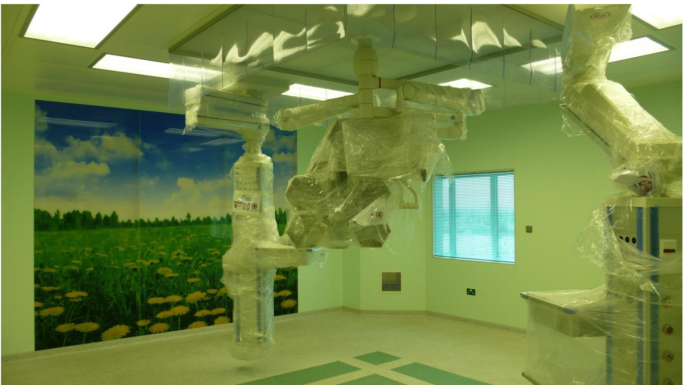
Kompletter OP-Saal mit bedruckter Wandverglasung, Verglasung und Abluftelement
