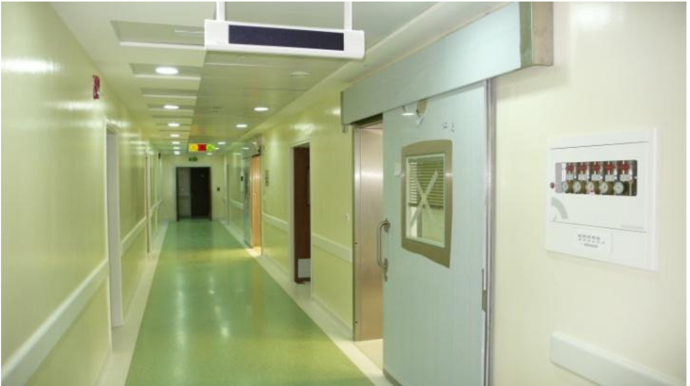
Flur mit dichtschießenden OP-Schiebetüren
