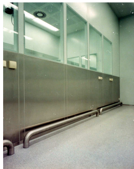
Wand mit Verglasung; Ausführung teilweise in Edelstahl
