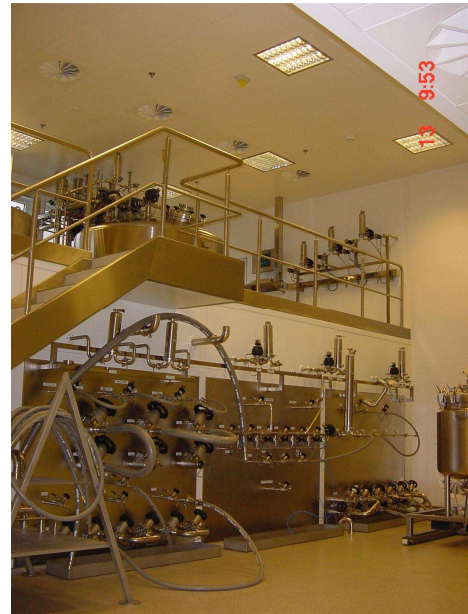
Ansatzraum, h=4.500 mm; Medienwand als Stahlrohrkonstruktion
