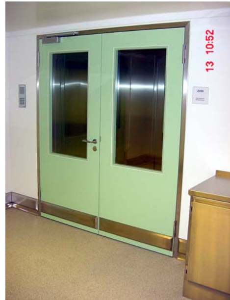
2-flügelige Drehtür mit Pharmaverglasung in Edelstahlzarge
