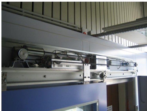
Laufschiene mit Antriebs- und Steuerungseinheit
