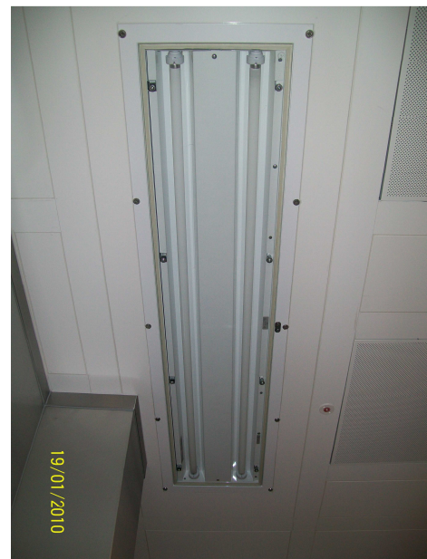
Ausführung: Ex-Einbauleuchte in Sonderkassette mit 100 mm breiten Alu-Profilen
