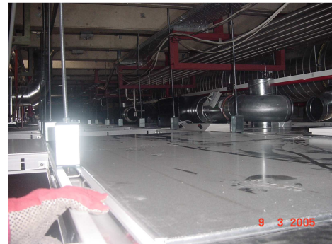
Rückseite Begehenebene bei Raster 1200x1200 mm
