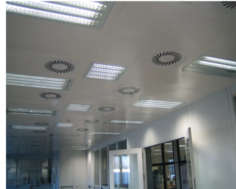
Ausführung: Raster 725x1450 mm, Öffnung 625x1350 mm mit 100 mm breiten Alu-Profilen bzw. Öffnung 625x625 mm mit zusätzlichen Querprofil, Kassetten Stahlblech, Oberflächen beschichtet, mit Einbauten
