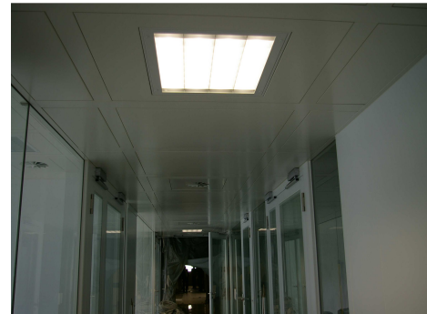
Ausführung: Raster 1200x1200 mm, Öffnung 1100x1100 mm, Ausschnitt für Einbauten 625x625 mm in Kassette, Kassetten Stahlblech, Oberflächen beschichtet, mit Einbauten
