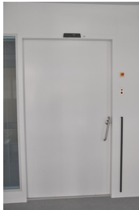
Automatisierte Schiebetür mit Rot-Grün Anzeige, Not-Aus Schalter sowie Schlagleiste
