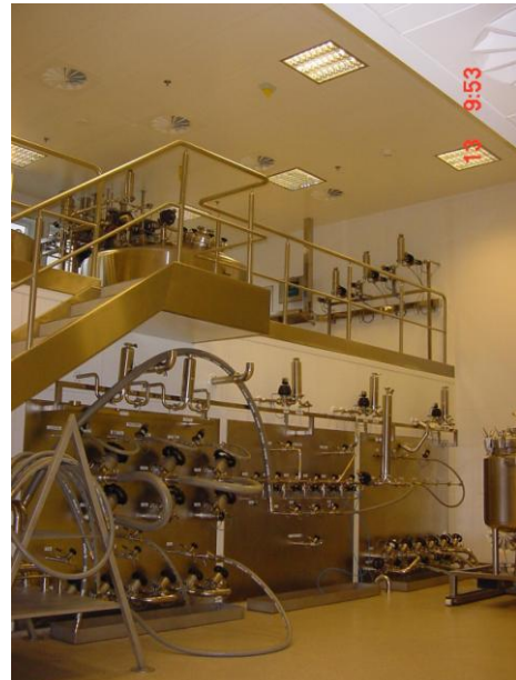
Ansatzraum, h=4.500 mm; Medienwand als Stahlrohrkonstruktion
