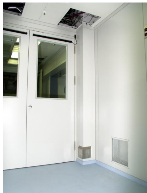
Sondereinbauten: Anfahrerschutz, Lüftungselement
